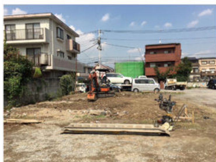
根切り地均し
