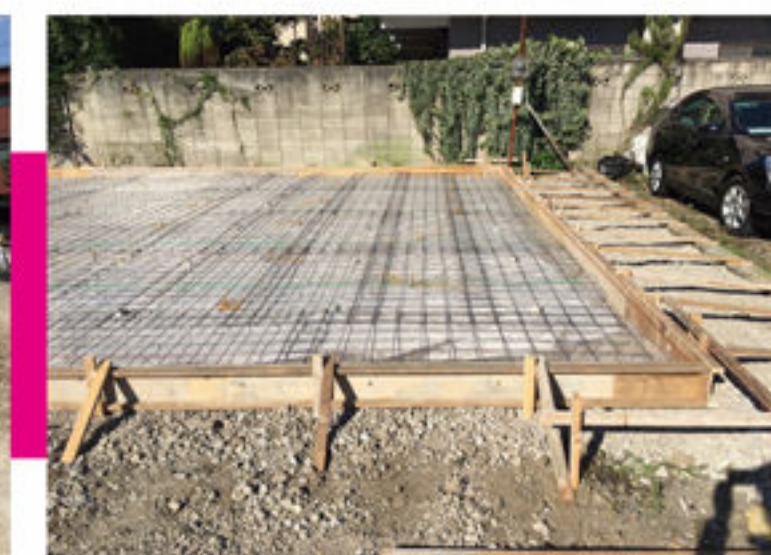
型枠組み・配筋
