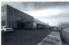
ゴトー工業新工場
